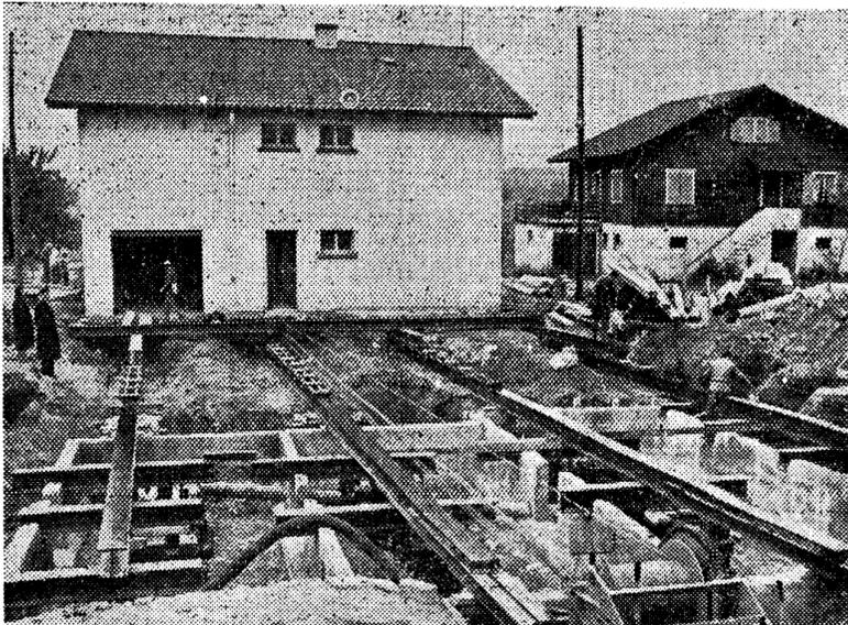
CASA SOBRE VIAS. — En Denges, Suiza, se ha procedido al difícil desplazamiento de una casita a lo largo de unos 80 metros, debido a la construcción de la autopista Lausana a Ginebra. En la foto, una vista de la delicada operación. En primer plano, los elementos donde estuvo asentada la casita.—(FOTOPIEL)
