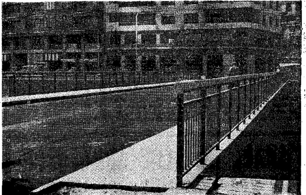
Hoy se realizarán pruebas de resistencia en el nuevo puente sobre nuestro Segura, que se espera esté inaugurado antes de fin de mes. Gran cantidad de camiones cargados con arena se aparcarán sobre él y permanecerán así el tiempo necesario para dar el visto bueno y poner el paso a disposición del público. Falta nos hace éste, y otros cuantos más, que despejen nuestro cada vez más agobiante tráfico. — (Foto LOPEZ.)
